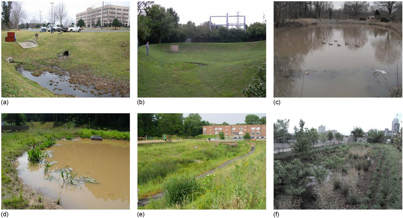
**Fig. 1.** Illustration of (a) Dry Detention 1 (DD1); (b) Dry Detention 2 (DD2); (c) wet pond (WP); (d) Wetland 1 (WL1); (e) Wetland 2 (WL2); and (f) bioretention (BR)
